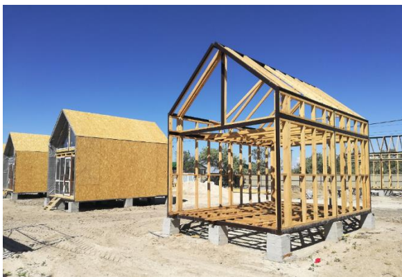
Рис. 5.2.4. Фундамент и каркас - главные компоненты дома
